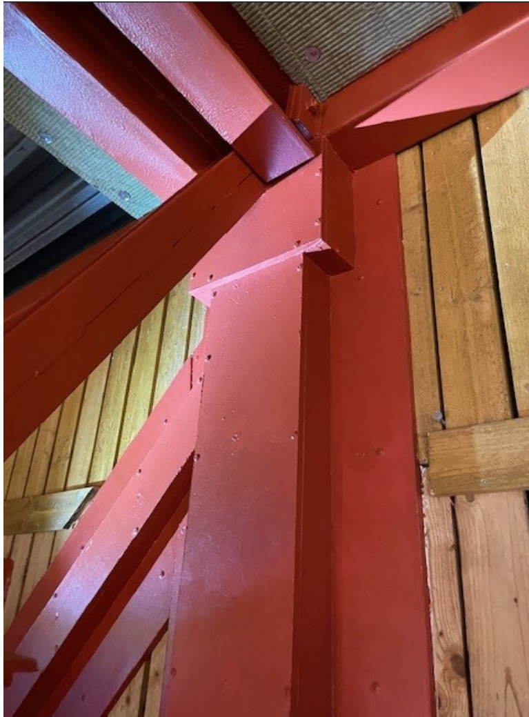
Brandinklädd pelare samt stabiliserande diagonaler.
